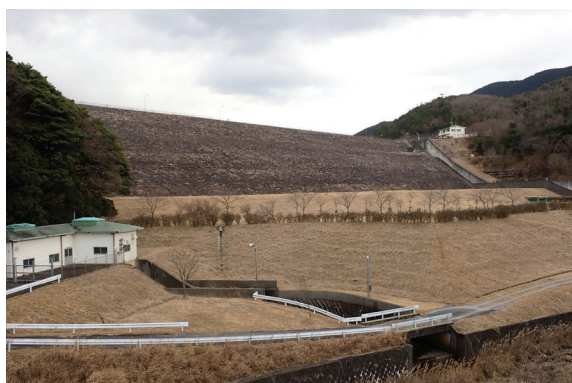
図 3. 蔵王ダム堤体.
